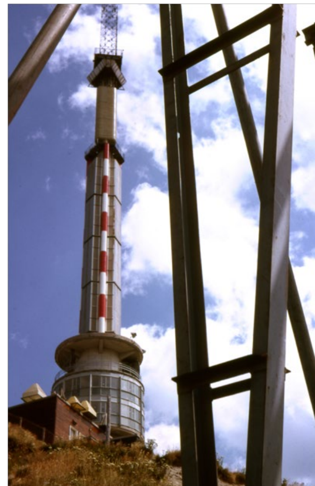
Relais de télécommunications (Ondes électromagnétiques)
